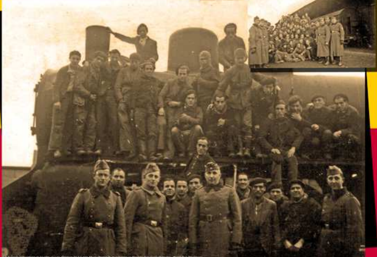
Les Espagnols travaillant sur le chantier pour les allemands (1) à la gare d'Angoulême et la manœuvre au Châtelet de la nuit (2) (Source : Musée de la Résistance)
